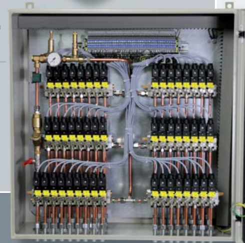
Steuerschrank mit 3/2-Wege-Magnetventilen zur Fernbetätigung von 49 Ventilen
